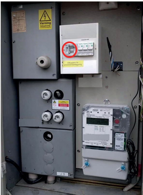
Mätplats med en ny låsbar elkopplare som är rätt placerad efter elmätaren.
