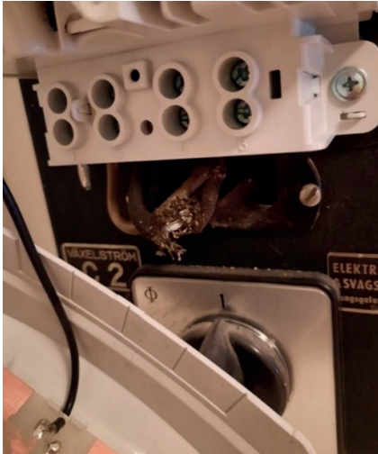
Strömförande kablar exponerade.
