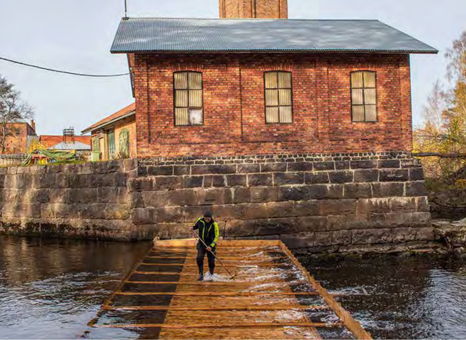
Ålfällan vid Forsbacka vattenkraftverk.
