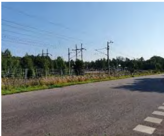
Figur 9: Vy över Lexevägen och järnvägen där Ledningen kommer att korsa dessa. Befintlig station ÄT411 syns i bakgrunden.
